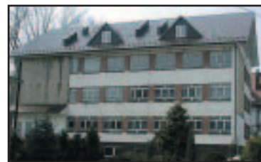
Nowy dach na Gimnazjum w Jodłownikach.
