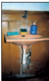
Standard wyposażenia łazienkowego przed remontem (Gimnazjum w Szczyrzycu).
