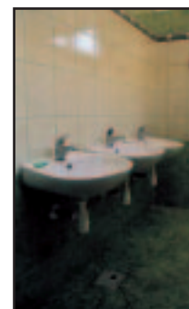
Standard wyposażenia łazienkowego po remoncie (Sz. P. w Szczyrzycu).
