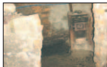
Przykład jednej ze starych kotłowni węglowych w placówkach oświatowych.
